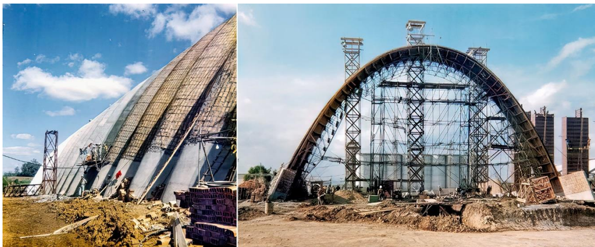
Figura 3: Armazém graneleiro, Estrela-RS.
