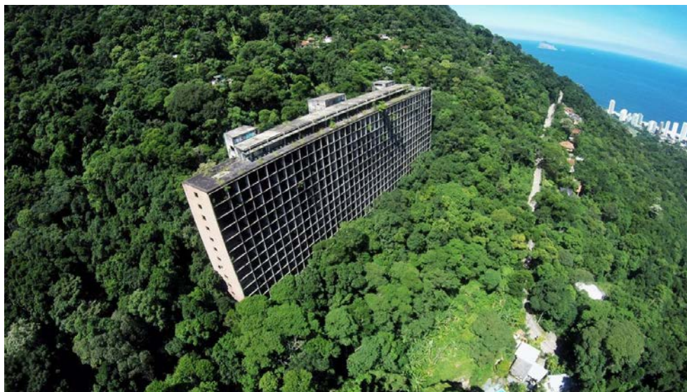
Figura 5: Estrutura abandonada do Gávea Tourist Hotel, 2016. Fonte: Site YouTube 8
