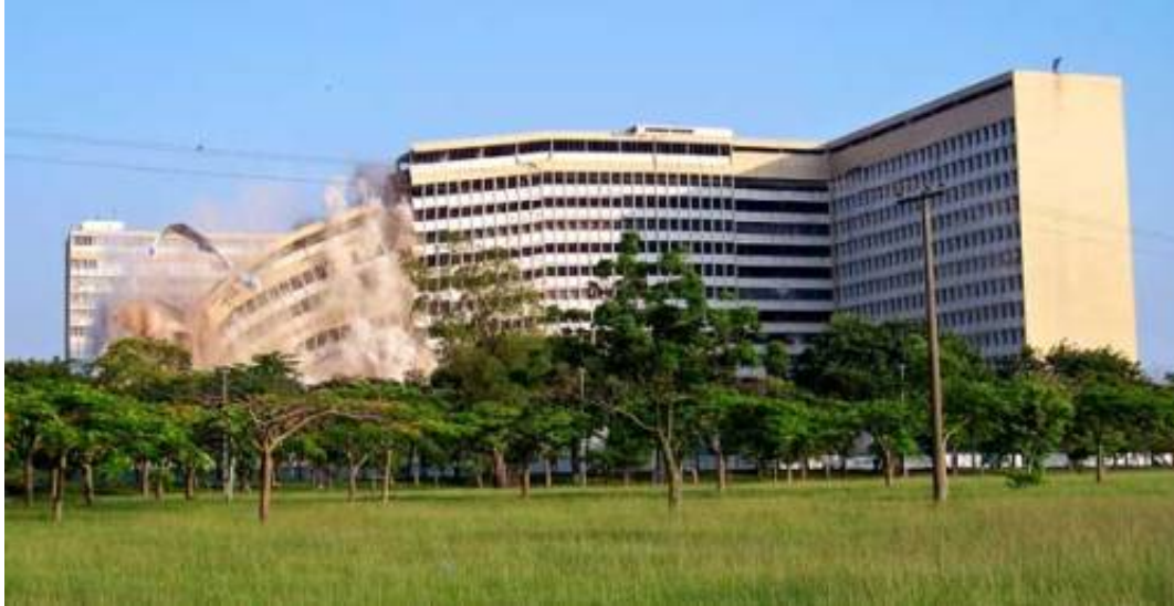
Figura 2: Implosão da "Perna-seca" do HUCFF, 2010.
