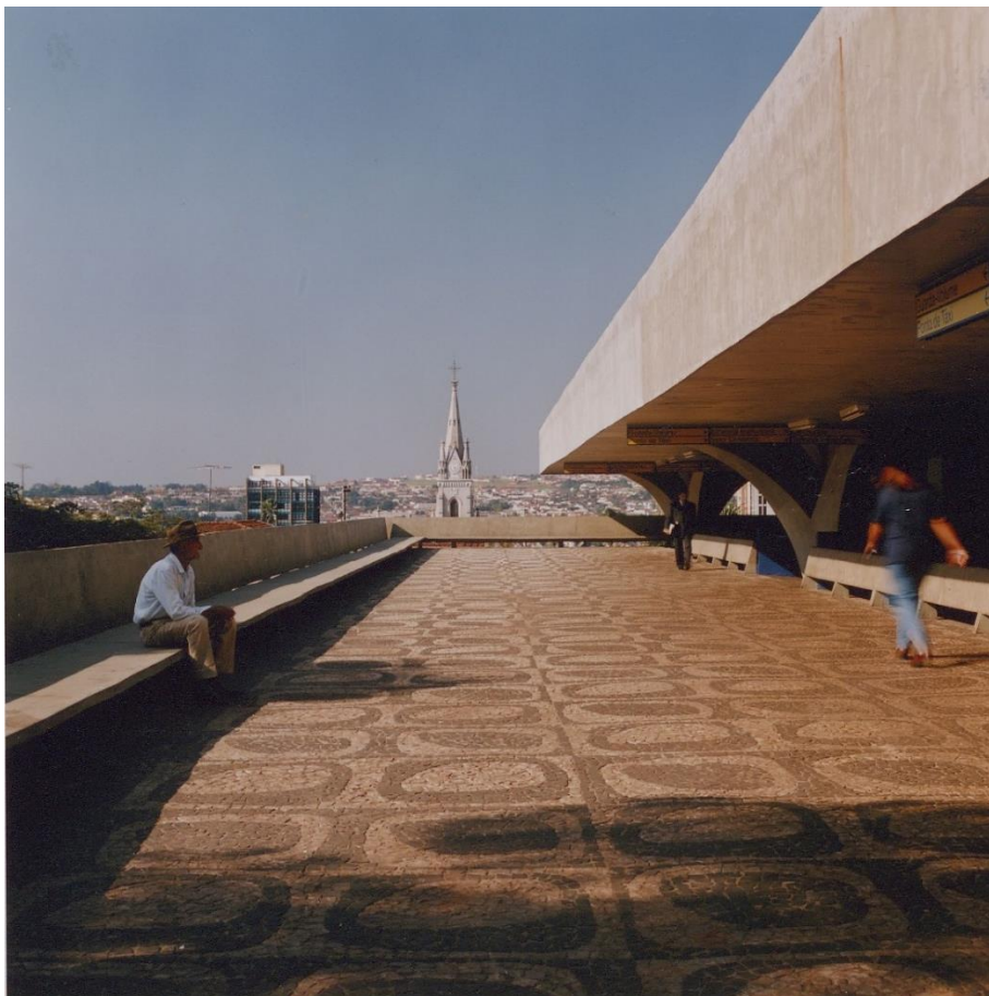
Figura 7: Estação Rodoviária de Jaú. Fonte: Acervo da Biblioteca da FAUUSP in: Arquigrafia.
