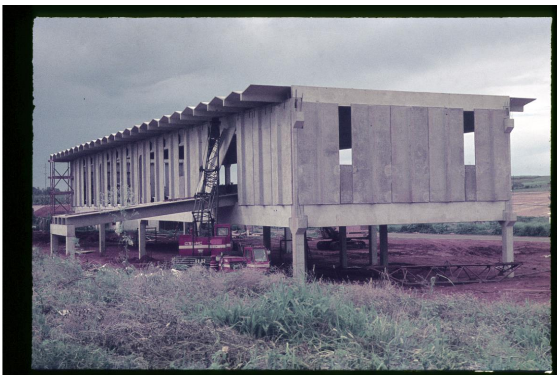
Figura 11: Construção pré-fabricada, Rodoviária de Sumaré. Fonte: Acervo da Biblioteca da FAUUSP in: Arquigrafia.
