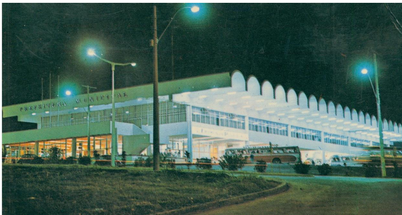
Figura 8: Prefeitura Municipal e Estação Rodoviária de Araçatuba – SP Fonte: Biblioteca do IBGE
