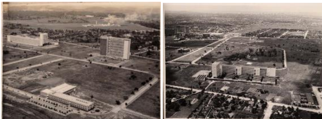
Figura 5: Vistas aéreas do Campus da UFPE na década de 1960: 1 Faculdade de Ciências Econômicas, em primeiro plano, Faculdade de Filosofia e Ciências Humanas (direita) e Faculdade de Engenharia (esquerda), em segundo plano; 2 Faculdade de Engenharia em primeiro plano. Fonte: Acervo: UFPE.
