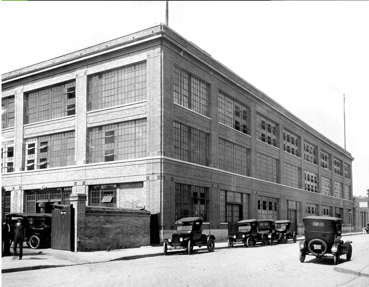
Figura 1: Fábrica da Ford em São Paulo, Brasil (1921), projeto de Albert Kahn. Fonte: Centro de Pesquisas Benson Ford.
